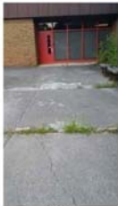
GLE Replace concrete sidewalks)
